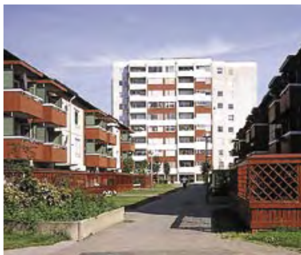
Övre Lövgårdets miljonprogramsområde i Göteborg. Energiförbrukningen för värme och varmvatten har minskat med cirka 30 procent sedan 1999, tack vare en systematisk jakt på energitjuvar.
